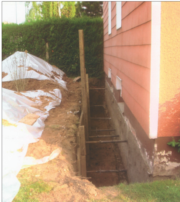
Ursache für Kellerfeuchte ist meist seitlich eindringendes Grund- und Sickerwasser. Da muss die Außenwand freigelegt und neu isoliert werden. Bild: Isotec
